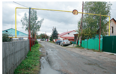
● Этим летом система центрального водоснабжения улучшена — запущена четвёртая скважина по программе «Чистая вода»
