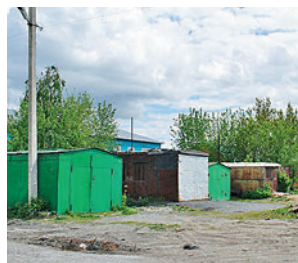
● Работы по благоустройству территории 1-го квартала начались с переноса гаражей
