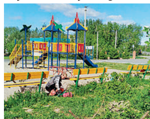
● Территорию у центра уже стали готовить к строительству парковой зоны
